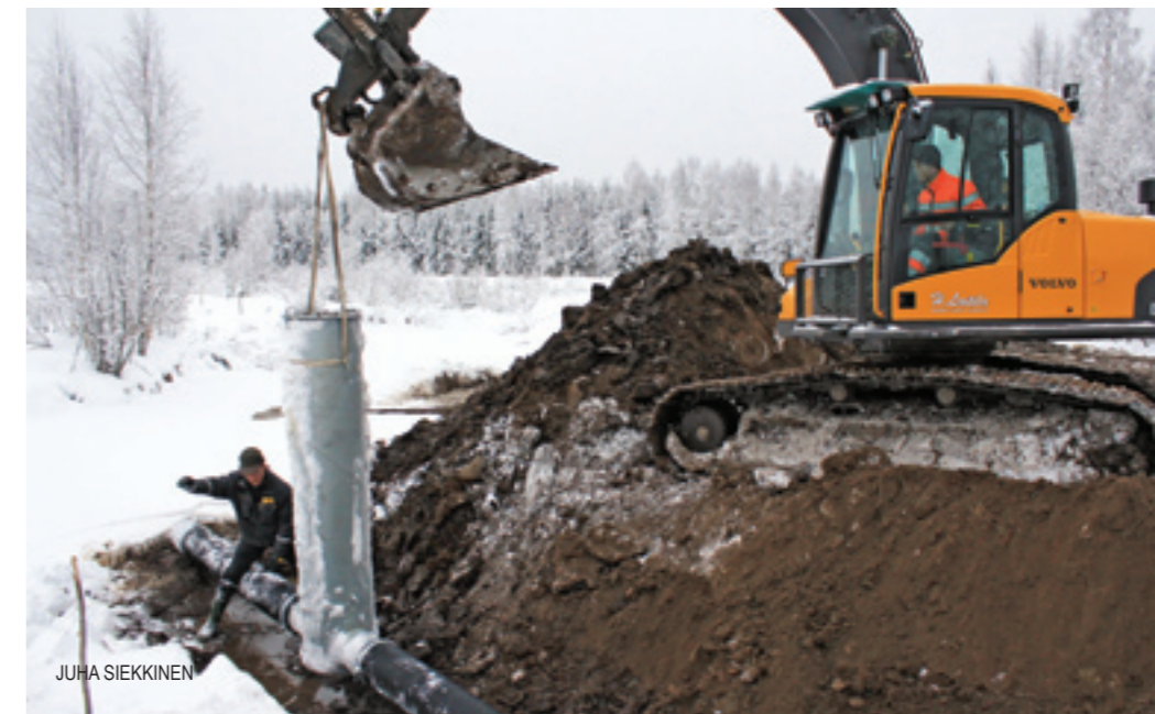
Kosteikon tyhjentämistä varten asennettiin metalliputkesta rakennettu munkkipato, jossa on veden tulo- ja poistoputkena muoviset rumpuputket.
